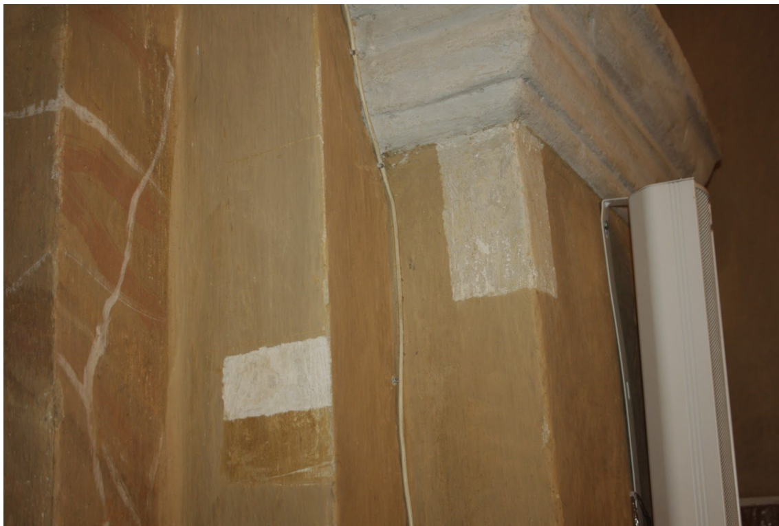
Fot. 49. Kościół p.w. św. Małgorzaty, dziewicy i męczennicy w Górze Świętej Małgorzaty. Ściana południowa, kapitel pilastra. Odkrywka pasowa nr 17. Fot. M. Kwiatkowski, 2021 r.
