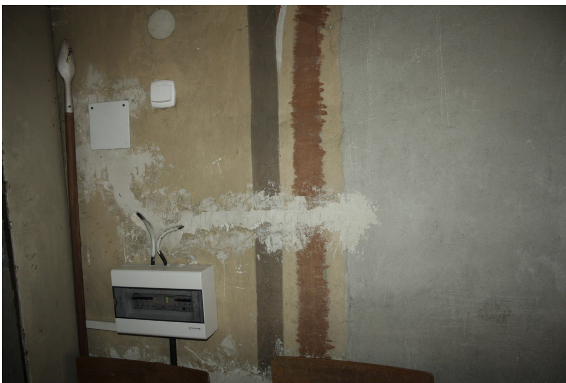
Fot. 20. Kościół p.w. św. Małgorzaty, dziewicy i męczennicy w Górze Świętej Małgorzaty. Ściana chóru. Widoczne łąty gipsowe, łuszcząca się warstwa malarska. Fot. M. Kwiatkowski, 2021 r.
