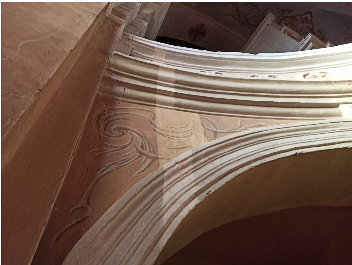
Fot. 31. Kościół p.w. św. Małgorzaty, dziewicy i męczennicy w Górze Świętej Małgorzaty. Balustrada chóru. Odkrywka płaszczyznowa nr 2. Fot. M. Kwiatkowski, 2021 r.
