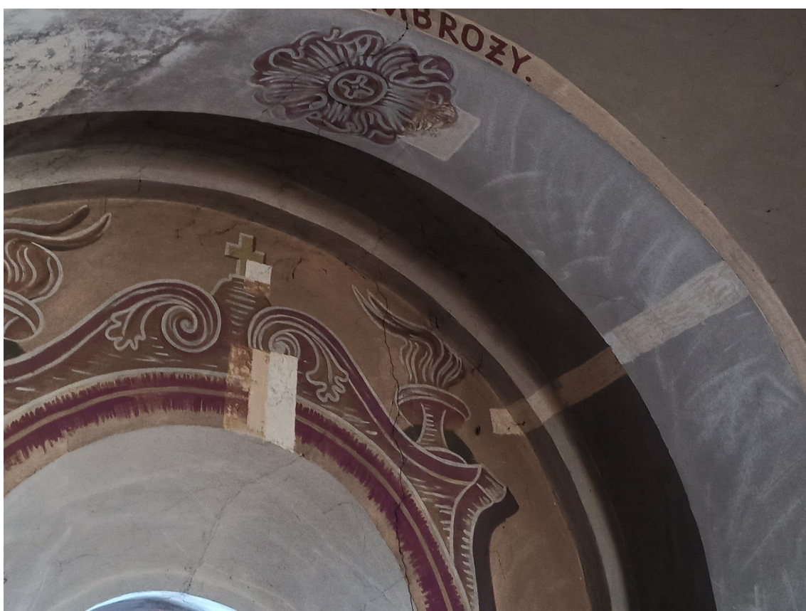
Fot. 36. Kościół p.w. św. Małgorzaty, dziewicy i męczennicy w Górze Świętej Małgorzaty. Ściana północna. Łuk nad ościeżem okna. Odkrywka płaszczynowa nr 6. Fot. M. Kwiatkowski, 2021 r.
