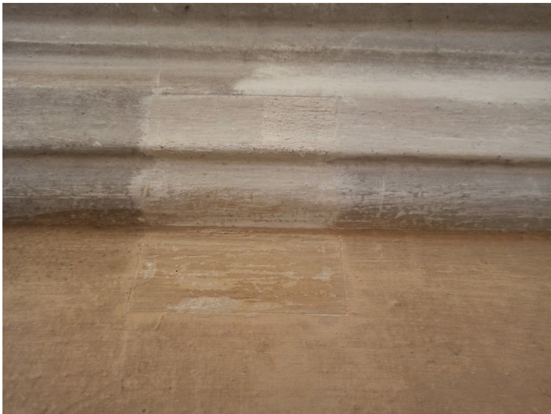
Fot. 47. Kościół p.w. św. Małgorzaty, dziewicy i męczennicy w Górze Świętej Małgorzaty. Ściana południowa-kapitel pilastra. Odkrywka pasowa nr 15. Fot. M. Kwiatkowski, 2021 r.
