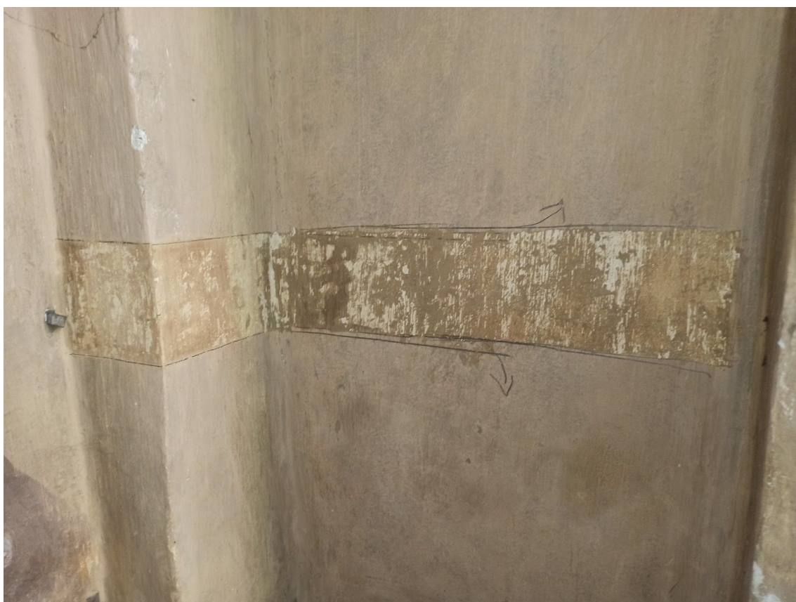
Fot. 46. Kościół p.w. św. Małgorzaty, dziewicy i męczennicy w Górze Świętej Małgorzaty. Ściana południowa, pilaster. Odkrywka płaszczyznowa nr 14. Fot. M. Kwiatkowski, 2021 r.
