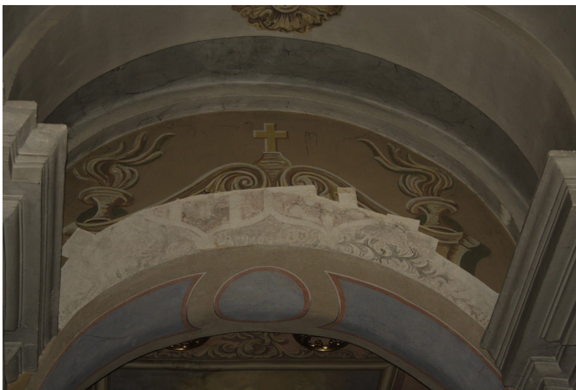
Fot. 40. Kościół p.w. św. Małgorzaty, dziewicy i męczennicy w Górze Świętej Małgorzaty. Ściana północna, łuk nad kaplicą Matki Boskiej. Odkrywka płaszczynowa nr 9. Fot. M. Kwiatkowski, 2021 r.
