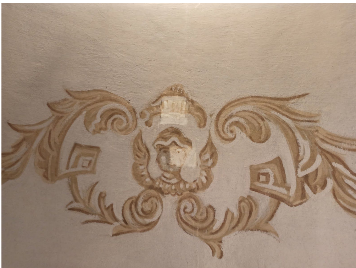
Fot. 32. Kościół p.w. św. Małgorzaty, dziewicy i męczennicy w Górze Świętej Małgorzaty. Sklepienie chóru. Odkrywka płaszczyznowa nr 3. Fot. M. Kwiatkowski, 2021 r.
