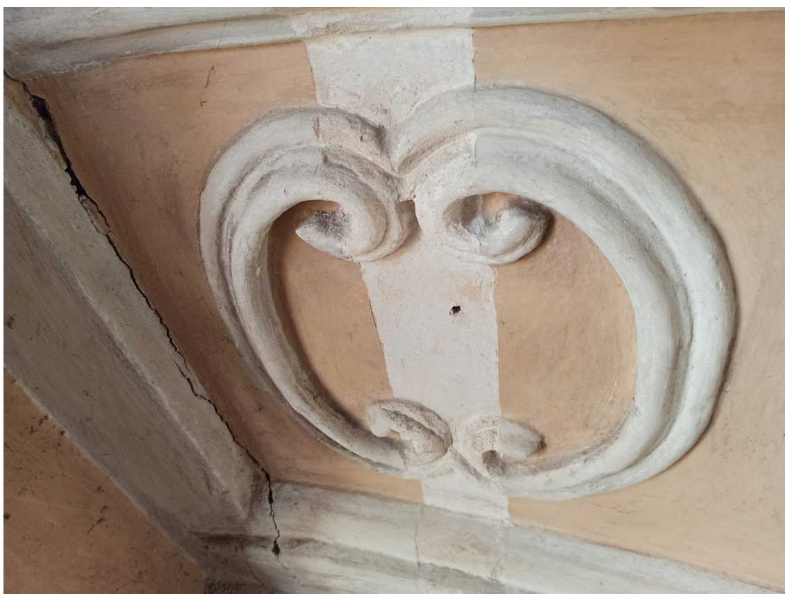
Fot. 30. Kościół p.w. św. Małgorzaty, dziewicy i męczennicy w Górze Świętej Małgorzaty. Balustrada chóru. Odkrywka płaszczyznowa nr 1. Fot. M. Kwiatkowski, 2021 r.
