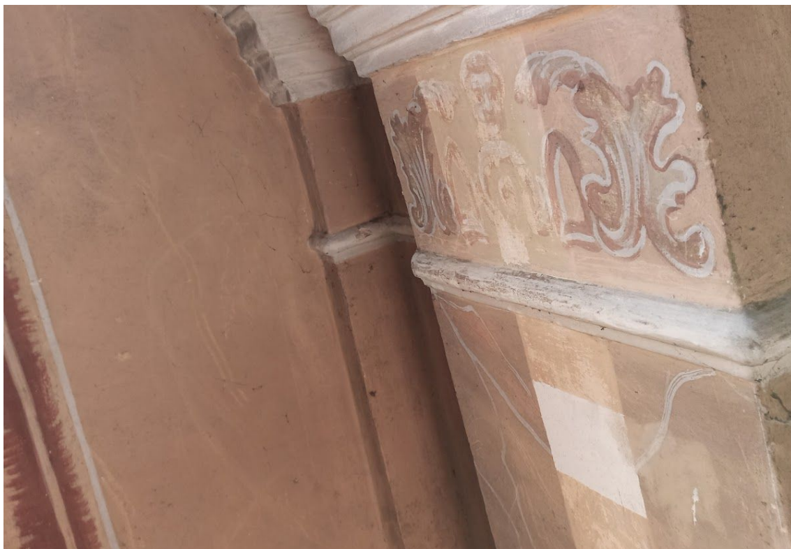
Fot. 44. Kościół p.w. św. Małgorzaty, dziewicy i męczennicy w Górze Świętej Małgorzaty. Ściana południowa, kapitel pilastra. Odkrywka płaszczyznowa nr 12. Fot. M. Kwiatkowski, 2021 r.
