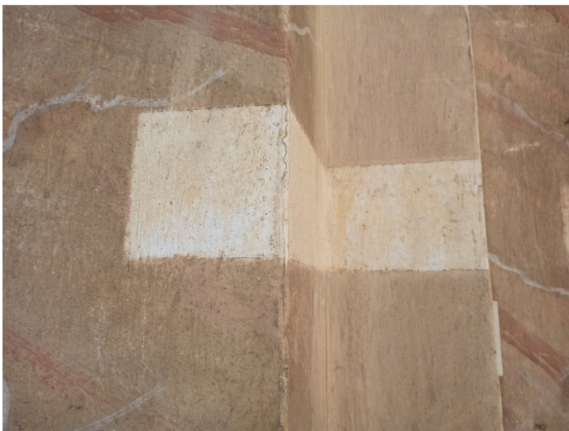
Fot. 50. Kościół p.w. św. Małgorzaty, dziewicy i męczennicy w Górze Świętej Małgorzaty. Ściana południowa, pilaster. Odkrywka pasowa nr 18. Fot. M. Kwiatkowski, 2021 r.
