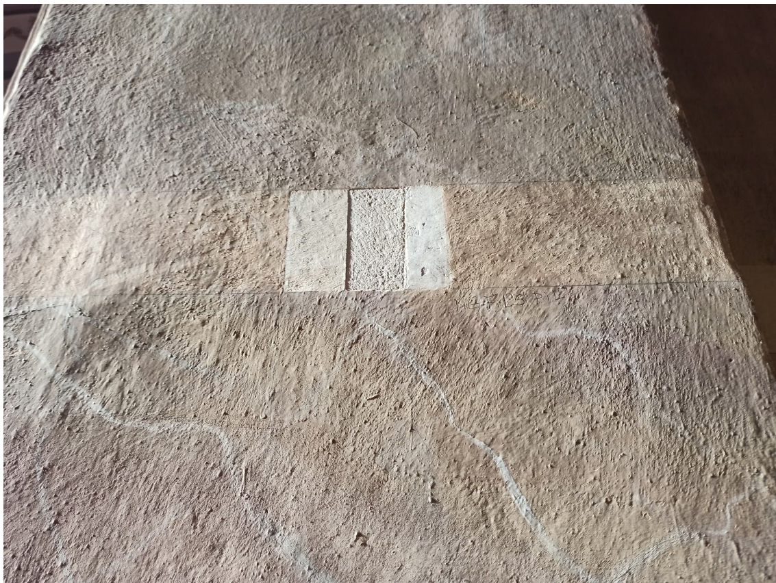
Fot. 41. Kościół p.w. św. Małgorzaty, dziewicy i męczennicy w Górze Świętej Małgorzaty. Ściana północna, pilaster. Odkrywka pasowa nr 10. Fot. M. Kwiatkowski, 2021 r.
