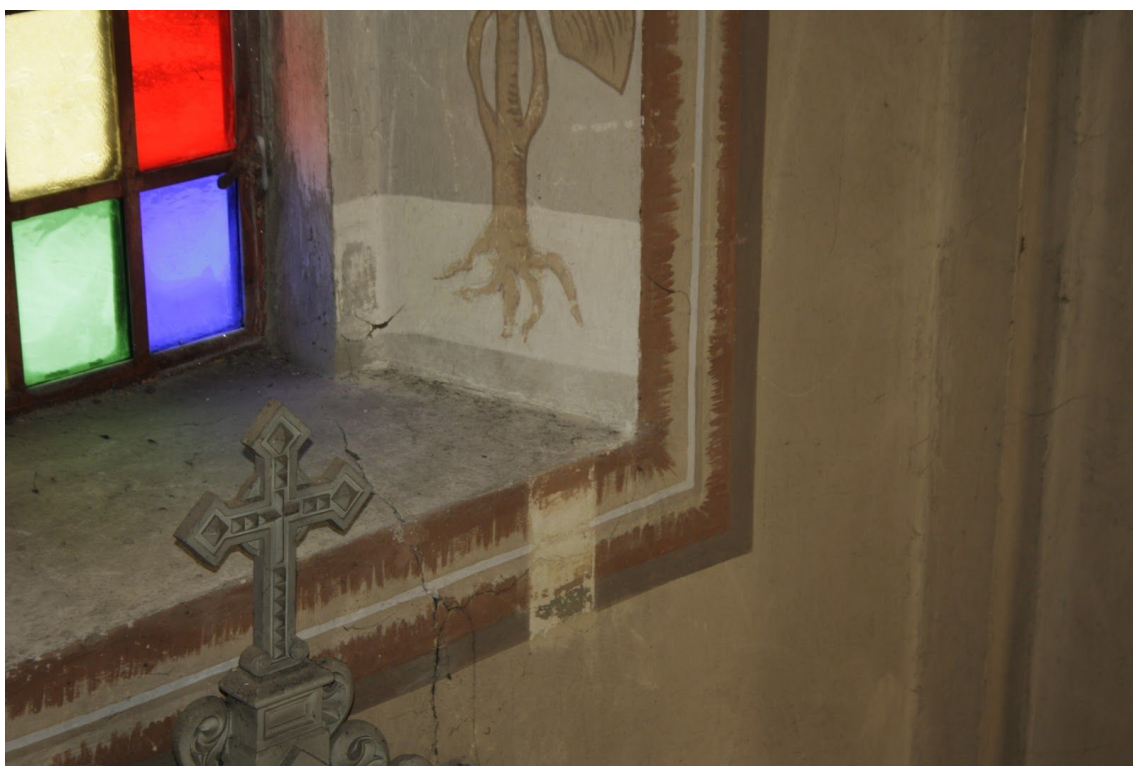
Fot. 38. Kościół p.w. św. Małgorzaty, dziewicy i męczennicy w Górze Świętej Małgorzaty. Ściana północna, ościeże okna. Odkrywka płaszczyznowa nr 8. Fot. M. Kwiatkowski, 2021 r.
