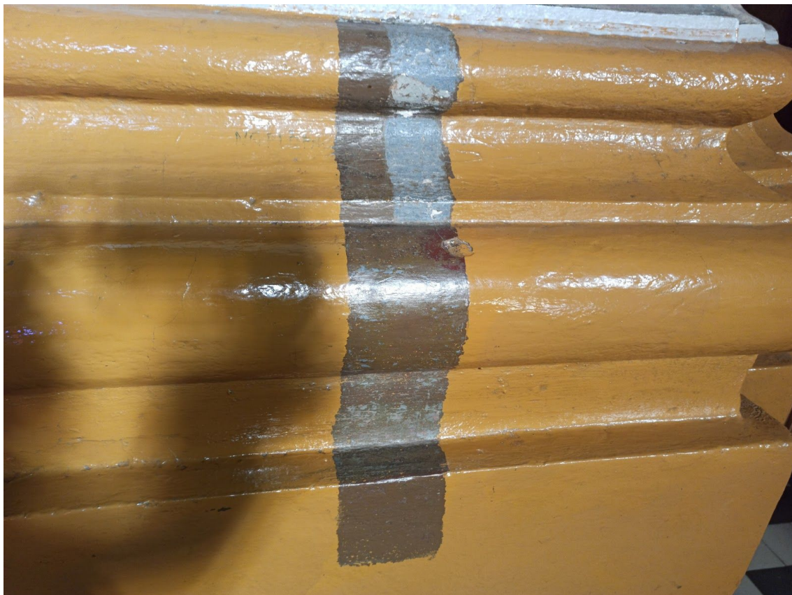
Fot. 37. Kościół p.w. św. Małgorzaty, dziewicy i męczennicy w Górze Świętej Małgorzaty. Ściana północna, bazy pilastrów. Odkrywka pasowa nr 7. Fot. M. Kwiatkowski, 2021 r.
