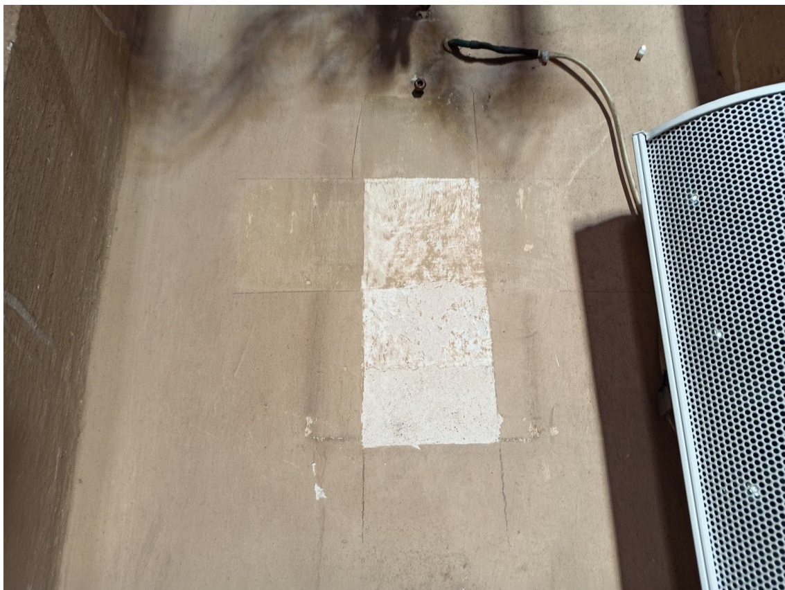
Fot. 42. Kościół p.w. św. Małgorzaty, dziewicy i męczennicy w Górze Świętej Małgorzaty. Ściana północna, pilaster. Odkrywka pasowa nr 11. Fot. M. Kwiatkowski, 2021 r.
