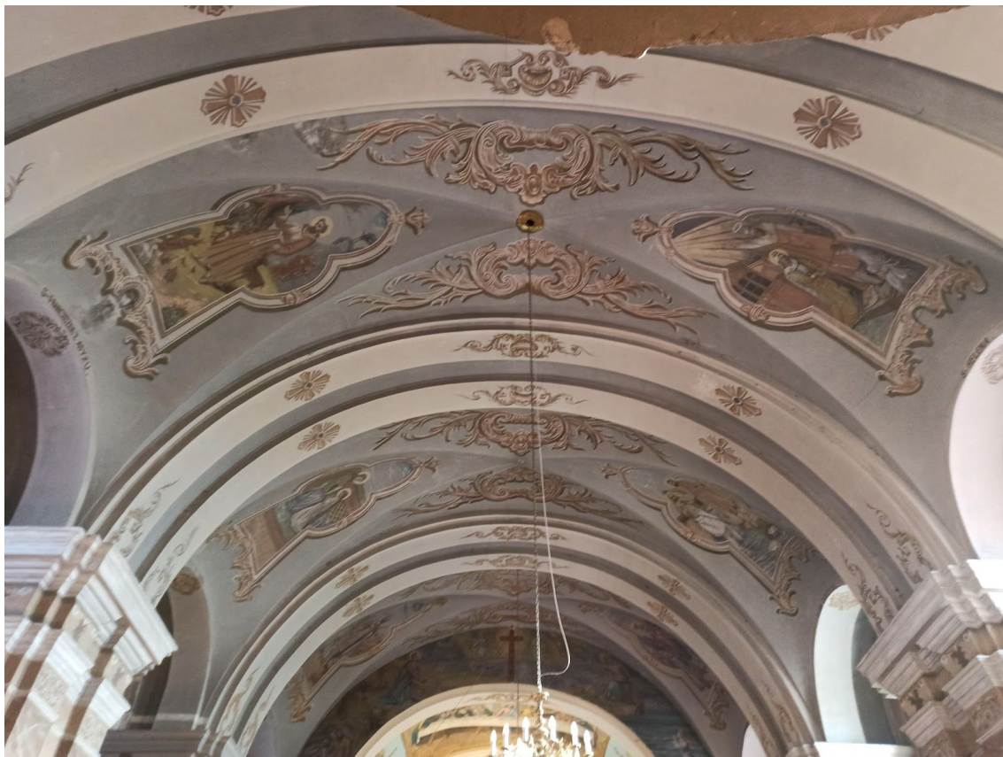
Fot. 3. Kościół p.w. św. Małgorzaty, dziewicy i męczennicy w Górze Świętej Małgorzaty. Sklepienie. Fot. M. Kwiatkowski, 2020 r.
